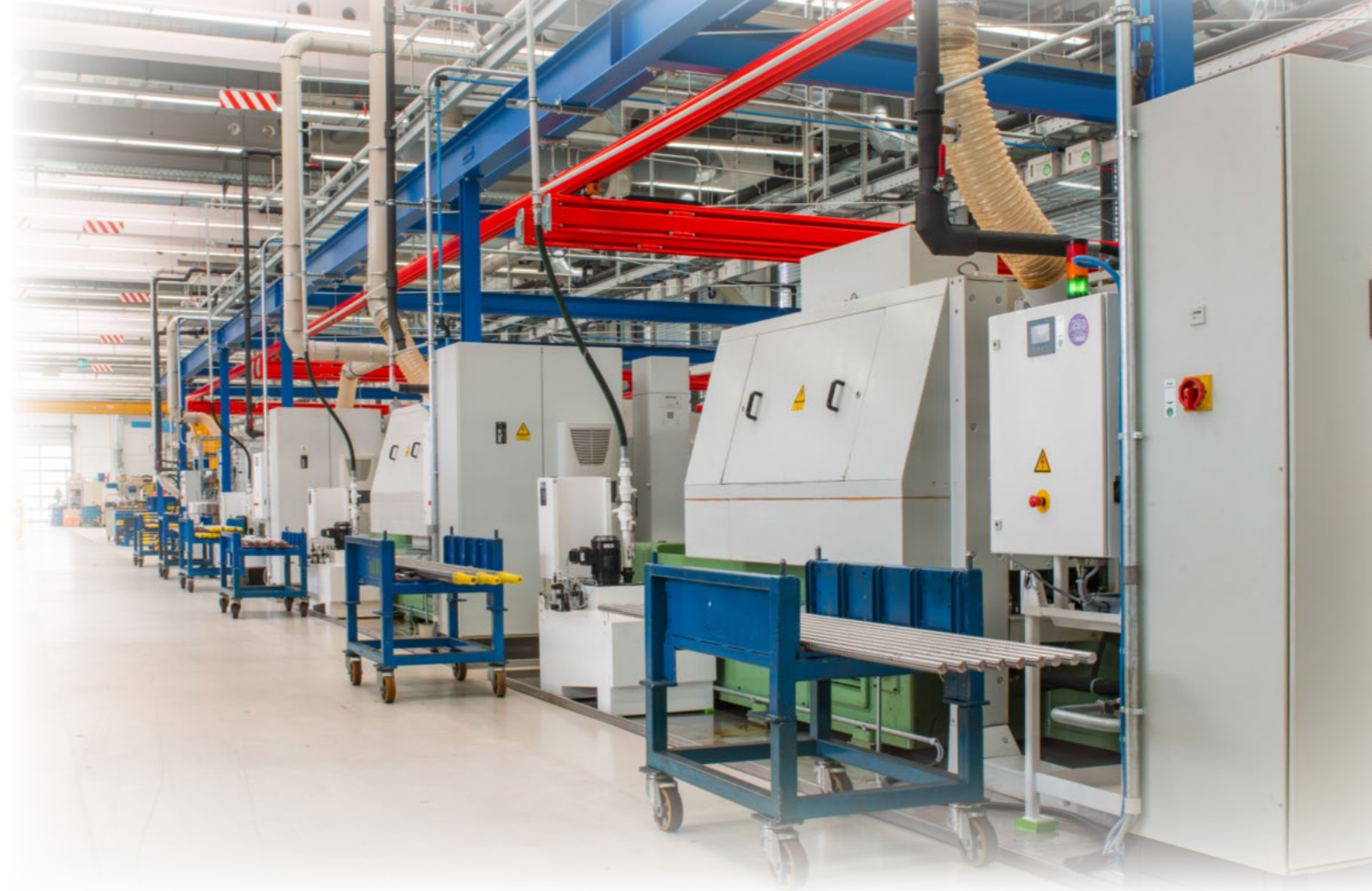
Unsere Gewindeschleifmaschinen sind komplett umgezogen
